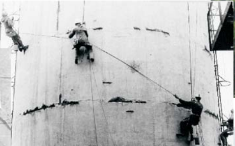
1985 KW Trattendorf: Beseitigung von Schadstellen an einem Schornstein
