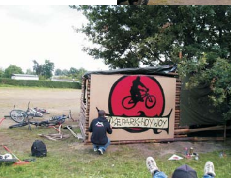
Bau des Bikerpark Hoyerswerda
